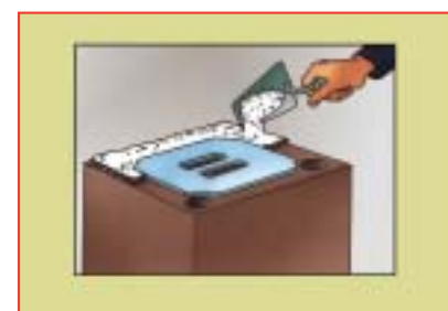
Rys. 6 Zastosowanie szablonu do zaprawy ułatwi jej nanoszenie oraz zabezpieczy tylne kanały wentylacyjne przed ich zabrudzeniem.
